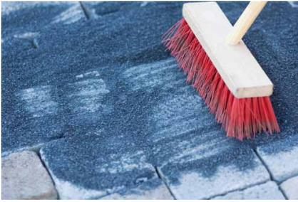
**3.** Die Fugen werden mit trockenem, gewaschenem Brechsand (0/2) oder mit Splitt (1/3) vollständig geschlossen. Wenn man die Sickerfähigkeit erhalten will, muss man Splitt verwenden, ansonsten Brechsand. Den Fugensplitt diagonal zu den Fugen auftragen.
