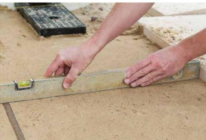
**1.** Auf die Tragschicht kommt jetzt noch eine Bettungs- und Ausgleichsschicht aus Brechsand-Splittgemisch, Korngröße 0/5 mm. Nach dem Verdichten wird mit einer Holzlatte die Fläche glatt gezogen. Nach dem Abziehen das Plattenbett nicht mehr betreten! Wenn mit Randsteinen gearbeitet wird, werden diese vor dem Anbringen der Bettungsschicht gesetzt.
