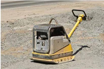
**2.** Schütten Sie lagenweise eine Trag- und Frostschutzschicht auf und verdichten Sie diese Schichten. Dazu verwenden Sie Kies oder Schotter (Körnung 0/32 oder 0/45). Diese Tragschicht muss ein Gefälle von mindestens 2% haben (das vom Haus wegführt). Mit Maurerschnüren und Wasserwaage können Sie das Gefälle am besten kontrollieren.
